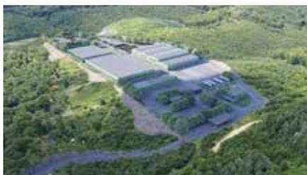
Projekt uključuje projektiranje i izgradnju Centra za gospodarenje otpadom Babina gora na području grada Karlovca i izgradnju 4 pretovarne stanice (Karlovac, Ogulin, Slunj i Otočac/Podum). Centar će biti dimenzioniran za obradu do 30.000 tona miješanog komunalnog otpada godišnje.
