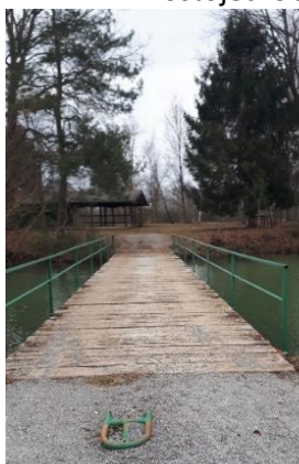
Postojeći most do otoka na Jezeru 1
