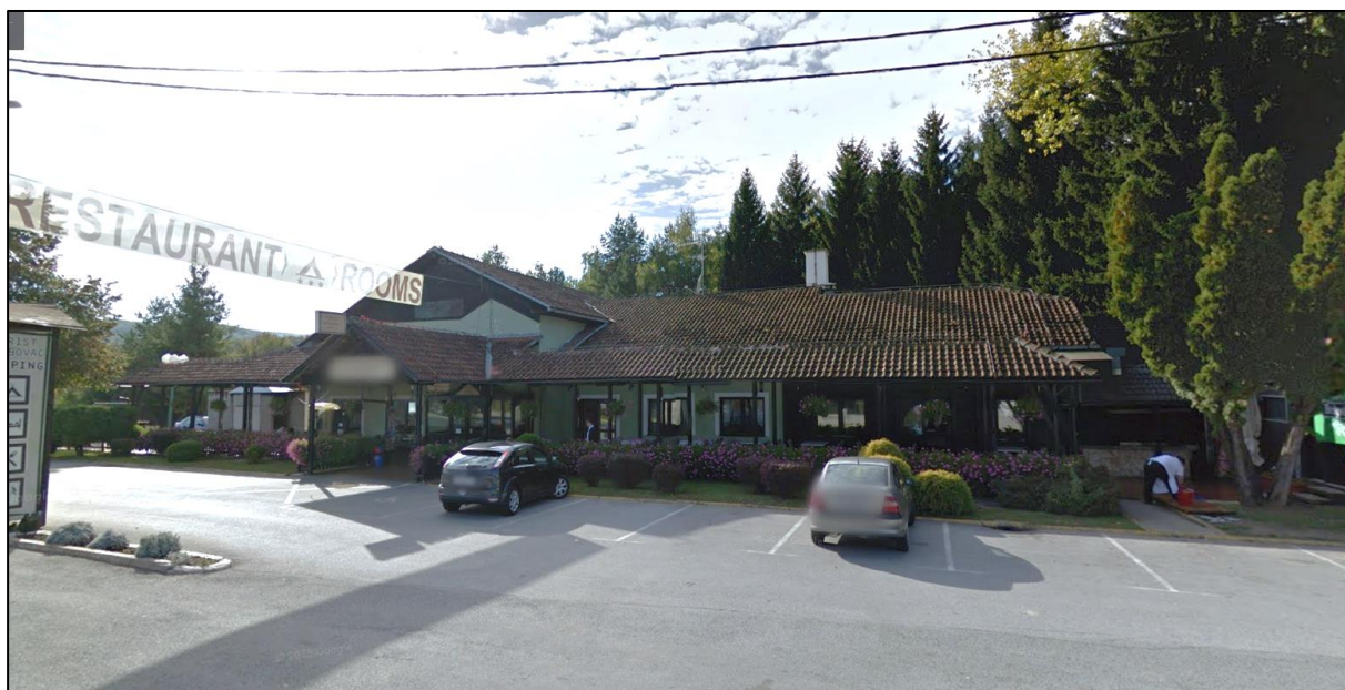
Slika 2.1.-1. Objekt restorana prije rekonstrukcije terase 2017. godine (izvor: Google)
